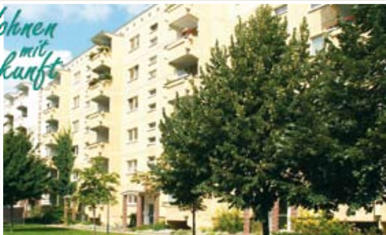
Eigentumswohnanlage in 10245 Berlin-Friedrichshain, Persiusstraße 10-19 / Markgrafendamm 26-28
