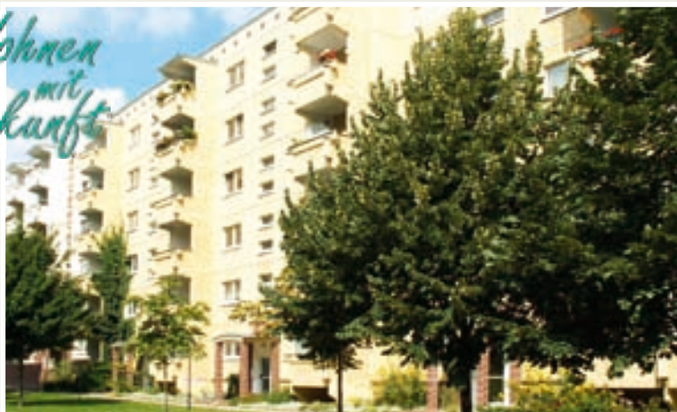
Eigentumswohnanlage in 10245 Berlin-Friedrichshain, Persiusstraße 10-19 / Markgrafendamm 26-28
