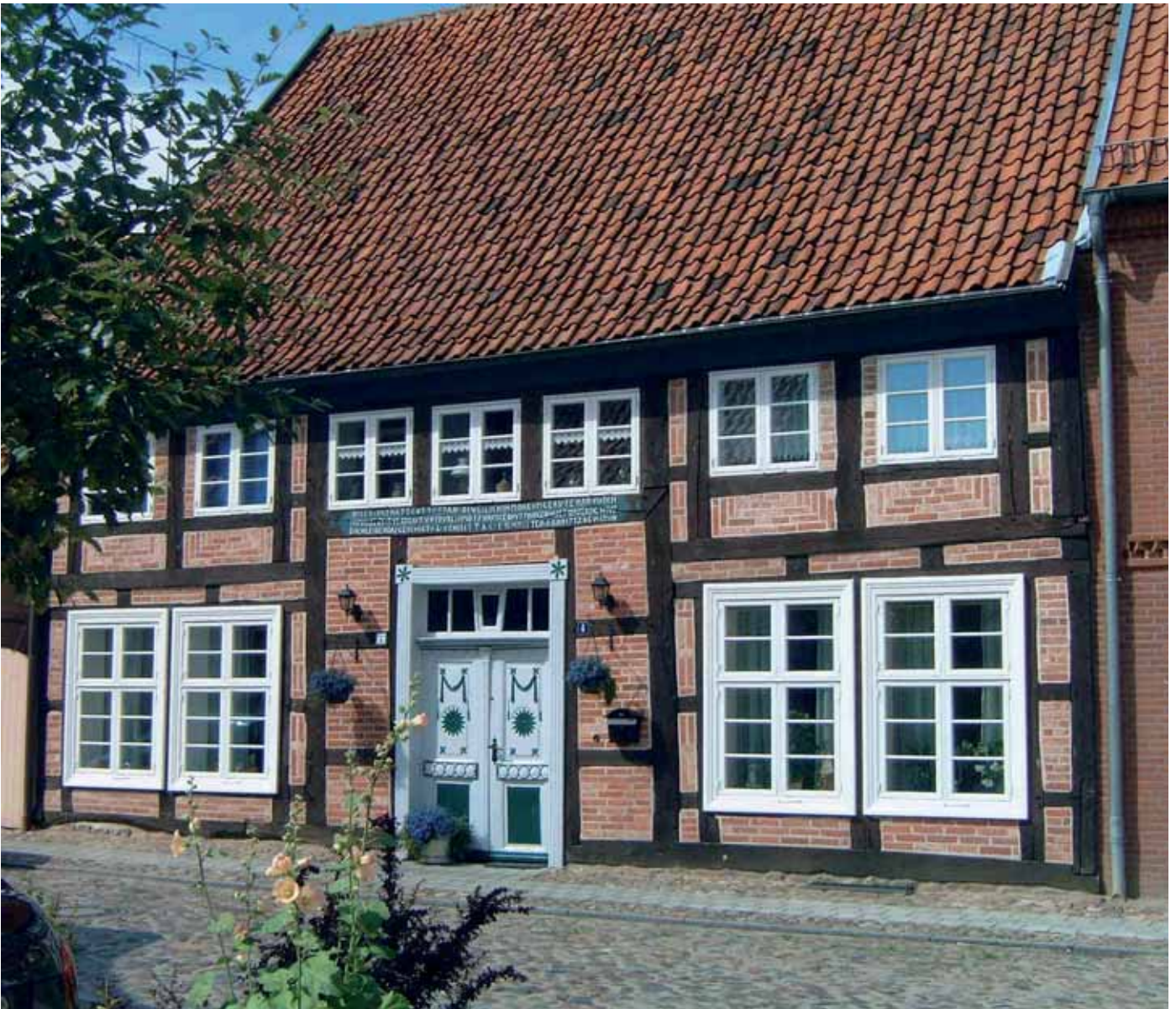
(Foto: Saniertes Ackerbürgerhaus)
